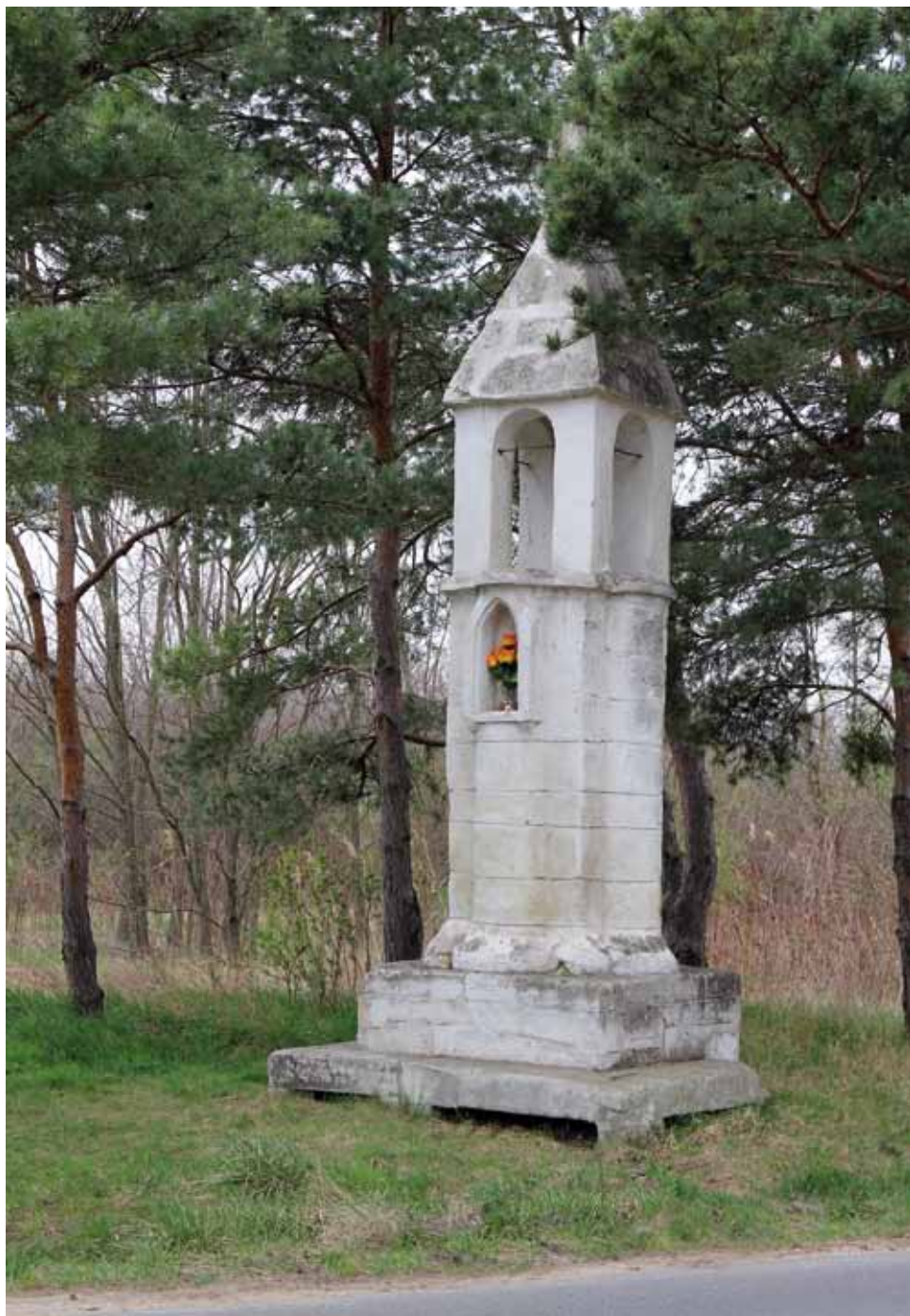
A Balfi úti Pihenőkereszt az állagvédelmi munkák elkészülte után, 2006
